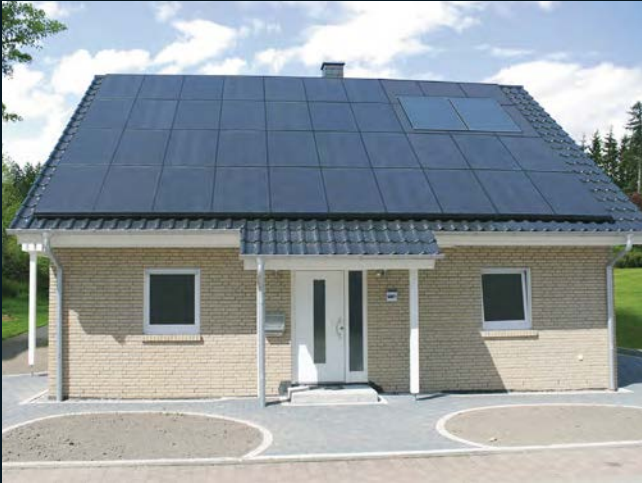
SOL-50 mit Verblendung von zwei Thermiekollektoren
