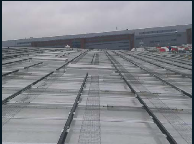
SOL-50 Direktmontage Energie-, Bildungs-, Erlebniszentrum Aurich (EEZ)
