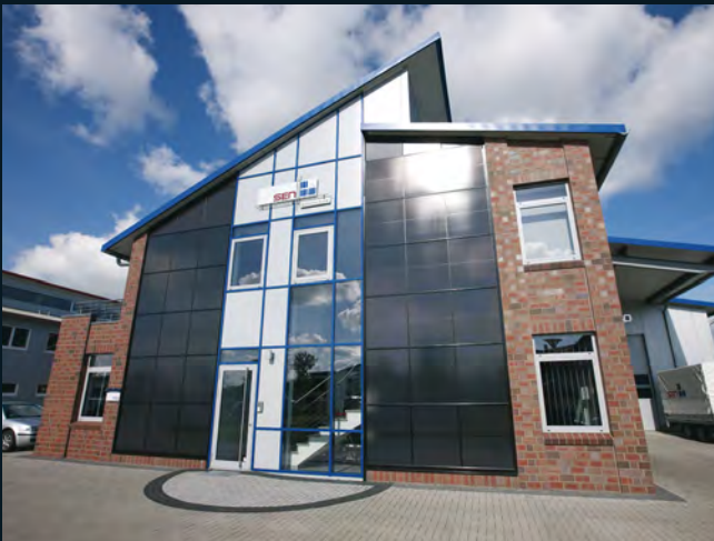
SOL-50 Fassadenanlage mit Verblendern in der Schräge
