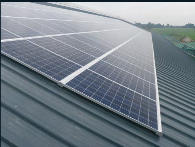
SOL-50 Trapezprofildach, Direktmontage
